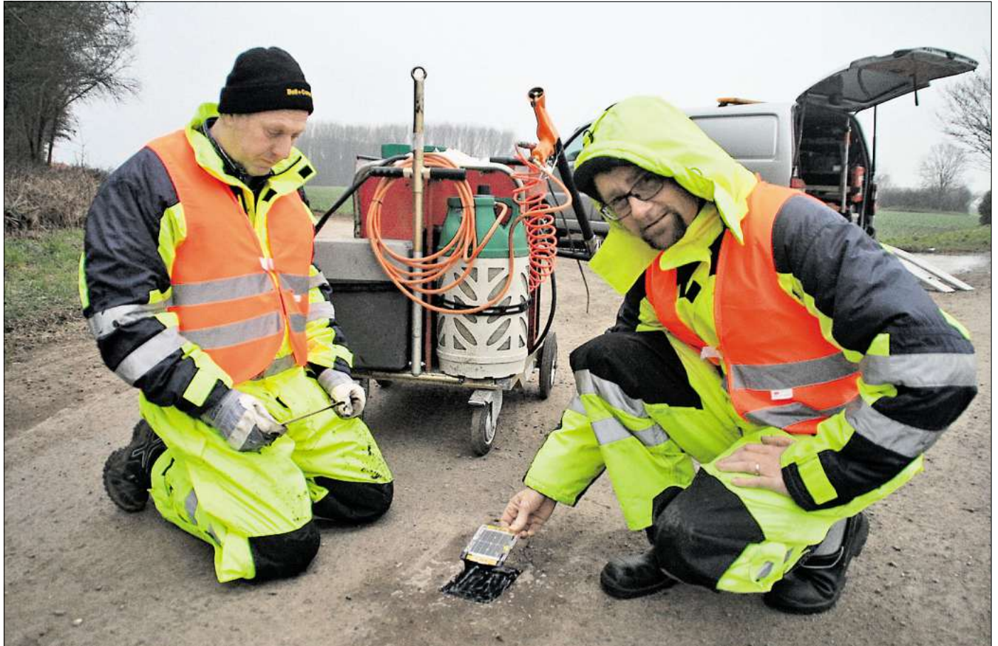
Hersteller Bruno Hansen (rechts) und Monteur Søren Pihl stecken in der Feldmark einen LED-Solarmarker in die vorgefräste Fläche.
