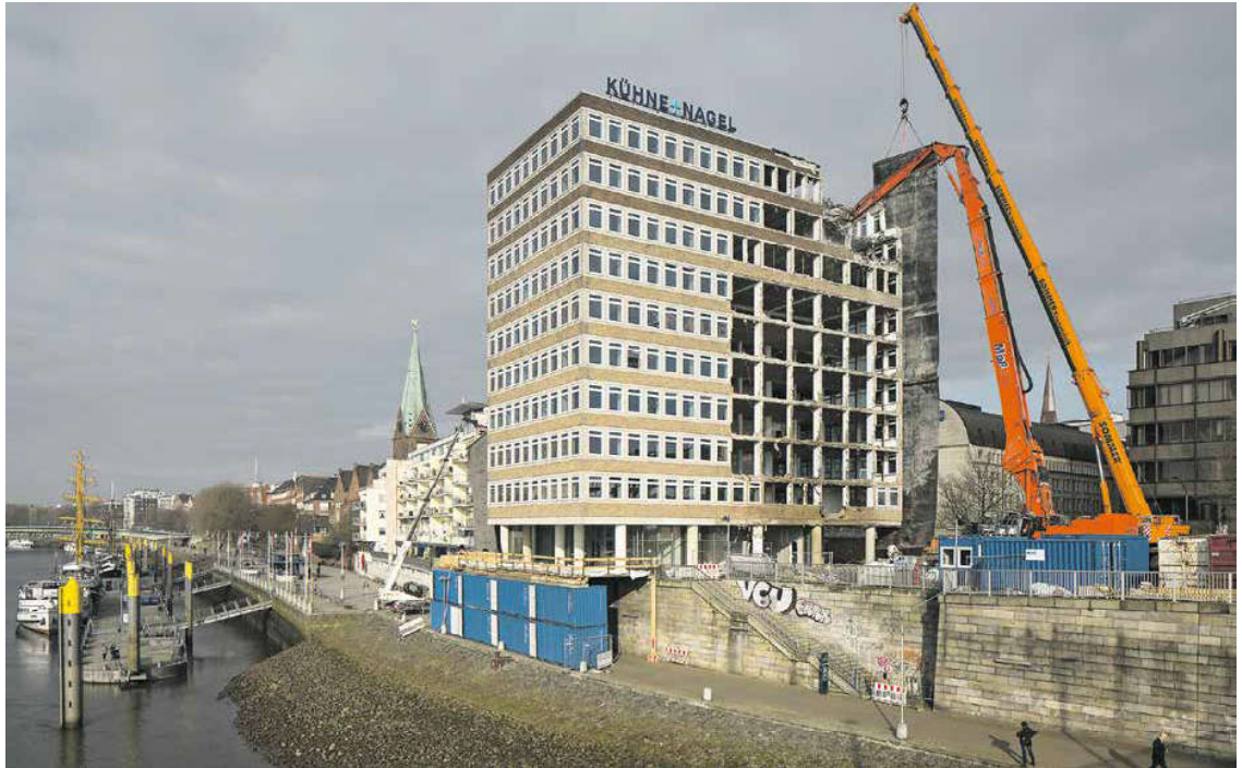
Anlass für Besinnung: Abriss und Neubau des Kühne+Nagel-Gebäudes in der Bremer Innenstadt Foto: Nikolas Wolff
